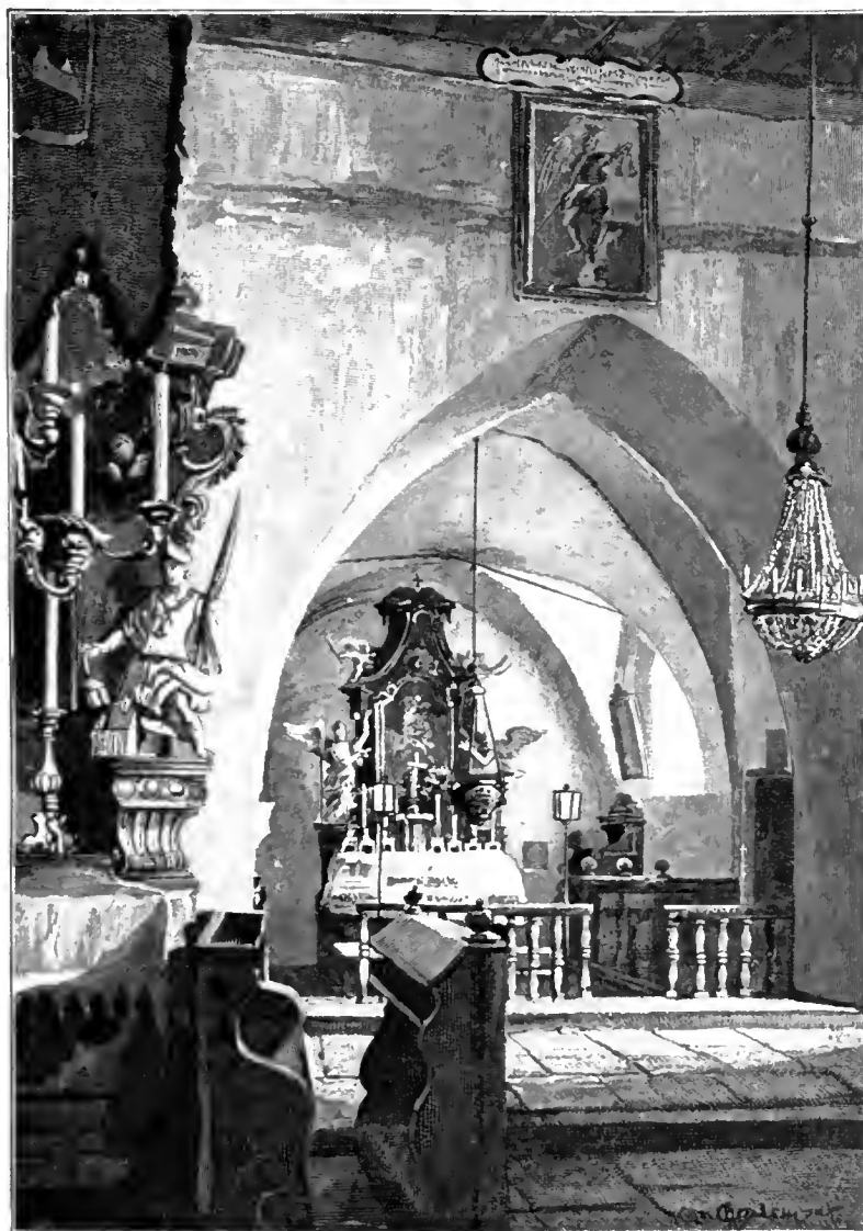
Innere der Kirche in Kostelec (bereits abgebrochen).
